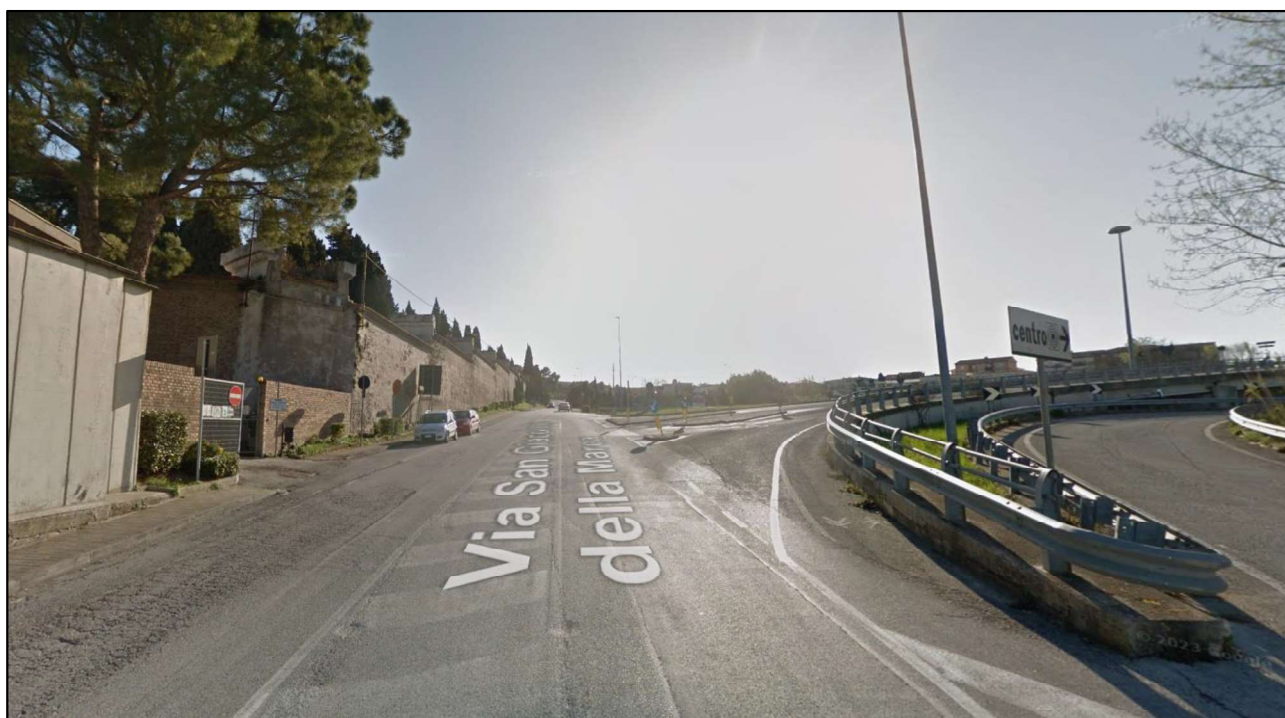
Figura 2. Ingresso n.2 e uscita Asse Nord-Sud
